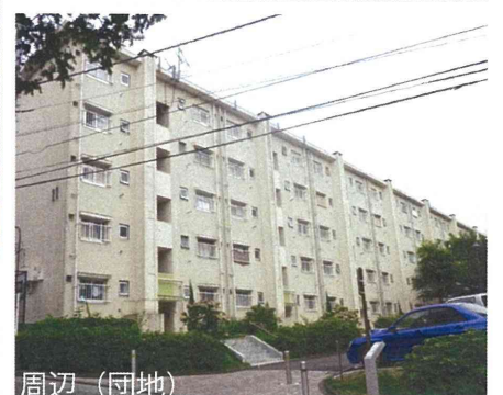
周辺 (団地内道路)
