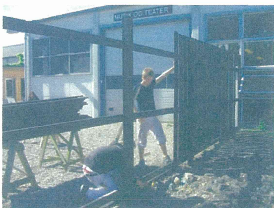
写真8 「木工」が製作する学内の塀
