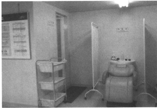
(写真左)患者汚染処置室(シャワー室)
