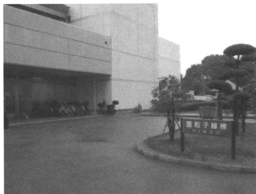
(写真左)重粒子線棟正面
