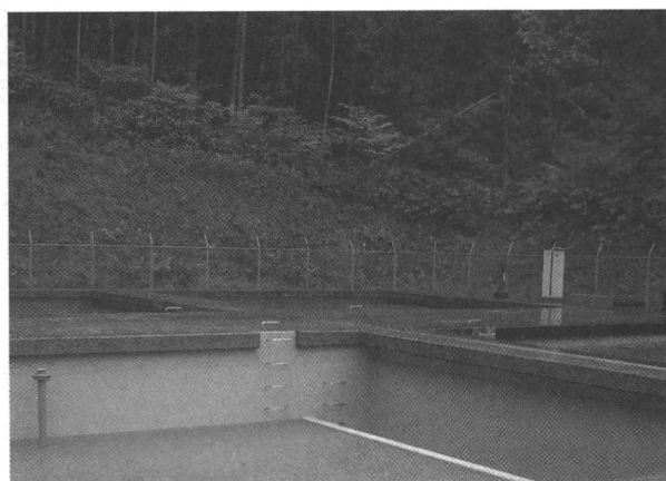
有刺鉄線（忍び返し）付きのフェンスは高さ十分
