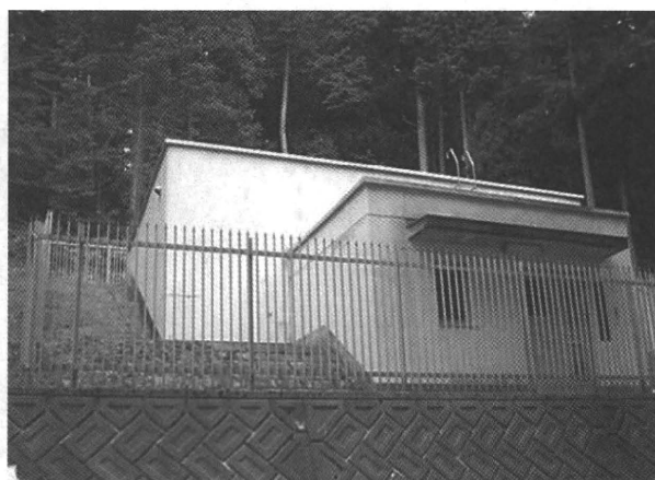
侵入防止用フェンスは高く鋭く有効
