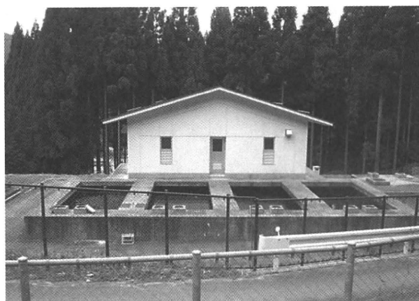
フェンスの高さは十分で、施錠もしてあるが、後方の林からの侵入に対しては全く無防備
