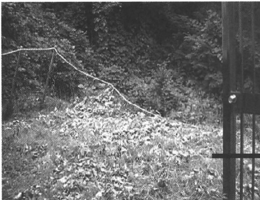
雪の重みでなぎ倒されたフェンスは保健所立入時まで放置されていた
