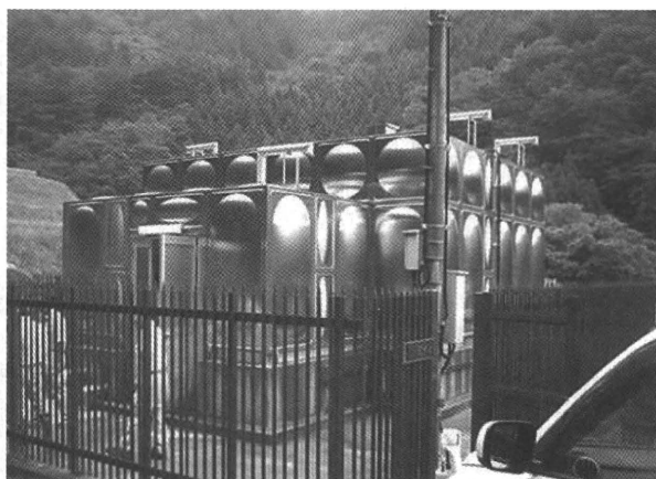
配水タンクは門、フェンスとも高く鋭い
