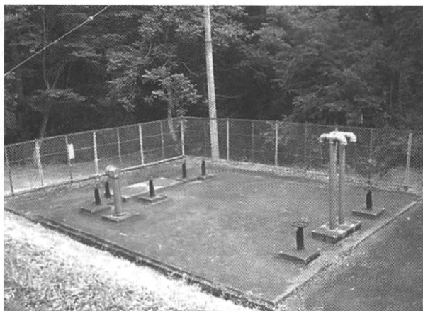
山間部の地下式配水池と侵入防止用フェンス
