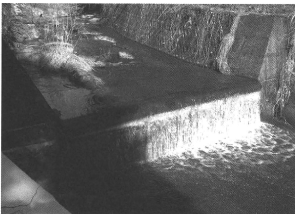
谷水、川水など表流水（河川水）の水源は多く、これは端に集水マスがあり、地下を通り貯水槽（沈砂池）へ流す
