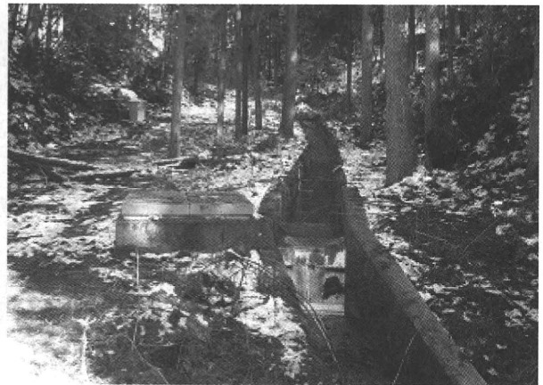
沢水から取水で人畜の侵入対策は困難
