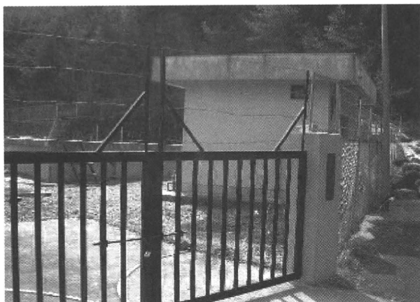
厳重な有刺鉄線をあとから設置し直した
