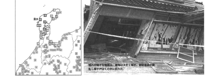
揺れの強さを物語る。建物は大きく傾き、家財道具が散乱し扉が壊れた。瓦は軒先から落ちてきた。
