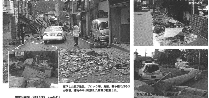
落下した瓦が散乱。ブロック塀、鳥居、墓や庭の灯ろうが倒壊。建物の中は倒壊した家具が散乱した。
