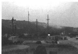
電線の復旧作業
