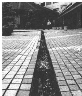
和倉温泉の旅館では敷き詰められたブロックが割れた。3月25日
