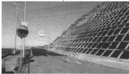
復旧状況 同上=10月25日
