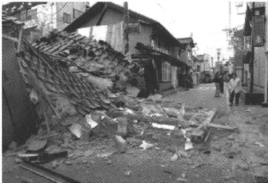
穴水町大町の被害家屋。 穴水町は輪島市に次いで全壊棟数が 多かった=3月25日
