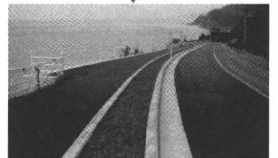
復旧状況 同上=10月25日
