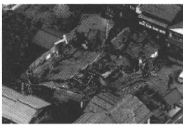
崩れた寺院=3月26日、輪島市門前町走出
