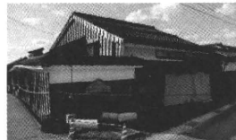
大きき被害があつた奥指定文化財(角海軍住宅) = 4月3日、輪島市庁舎前
