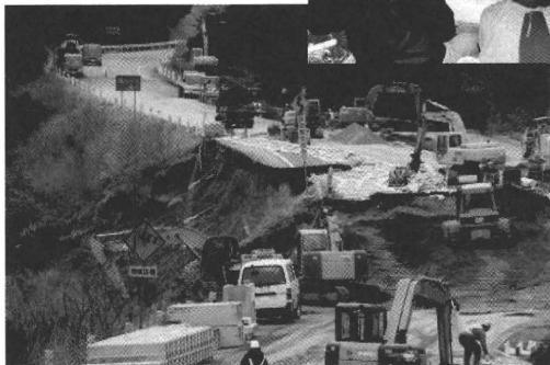
供用再開に向けて応急復旧工事が進められる能登有料道路=4月、七尾市中島町小牧
