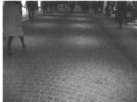
写真 1-6-12 コンコース床材 (セラミック系)
