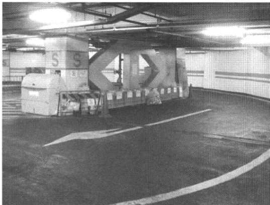
写真 1-6-3 車路の一部を使用して保管
