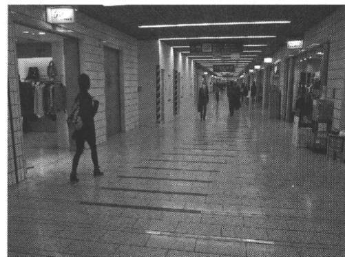
写真 1-6-13 コンコース床材 (石材系)
