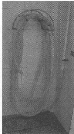
<ホースはホースラック>
