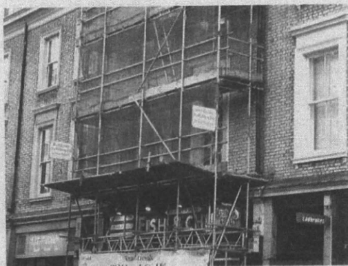
イギリスにおける落下物防護の例
