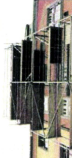
写真2 足場板の状況
