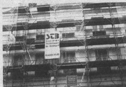
手すりわくを用いた先行足場の例
