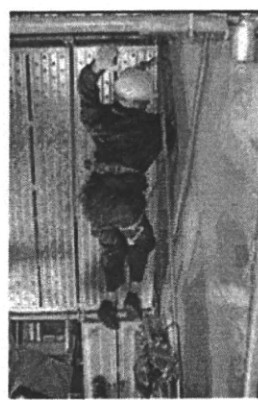
写真2 交さ筋かいの下に倒れ込んだ状態
