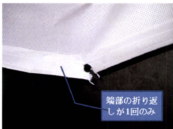
写真18 落体の墜落の衝撃で脱落したはとめ部分
