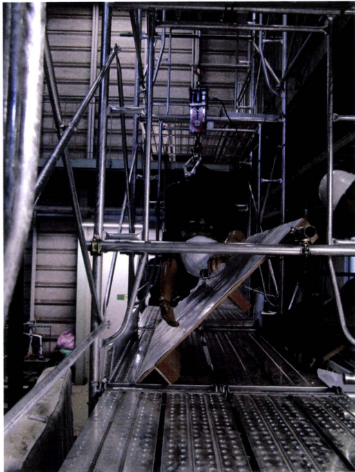
写真 30 幅木 B の実験前の状況
