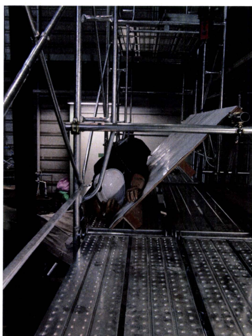
写真 29 幅木 A の実験後の状況
