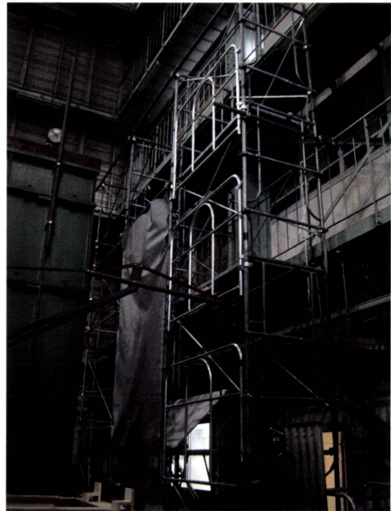
写真1 一部手すり先行工法により組立てた足場
