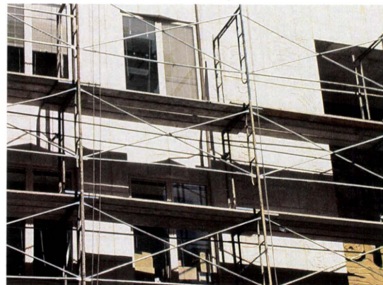
写真 20 交さ筋かい+中さん（下さん）を設置したわく組足場
