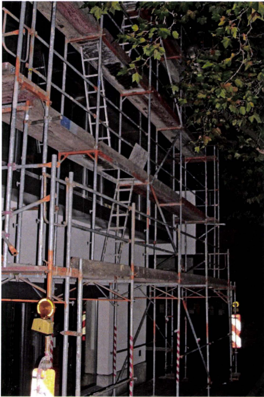
写真1 ドイツにおける足場の設置状況
