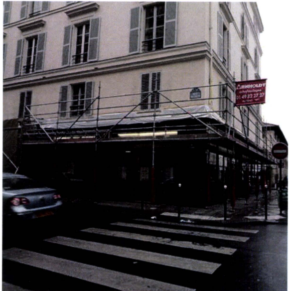
写真8 手すりの設置状況（複数の手すりがくさびの部分で設置されている）
