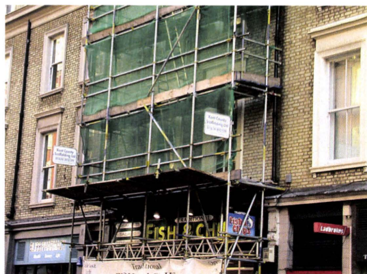
写真 17 落下物防護用の Fan の設置状況
