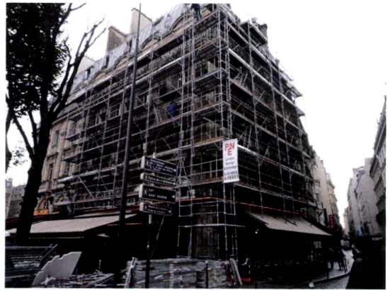
写真7 フランスにおける足場の設置状況
