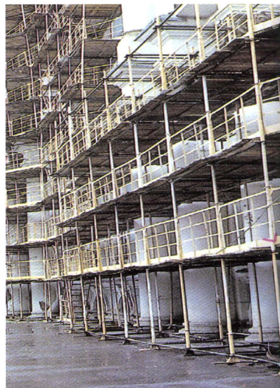
写真 34 タイにおける墜落防止性能の高い足場
