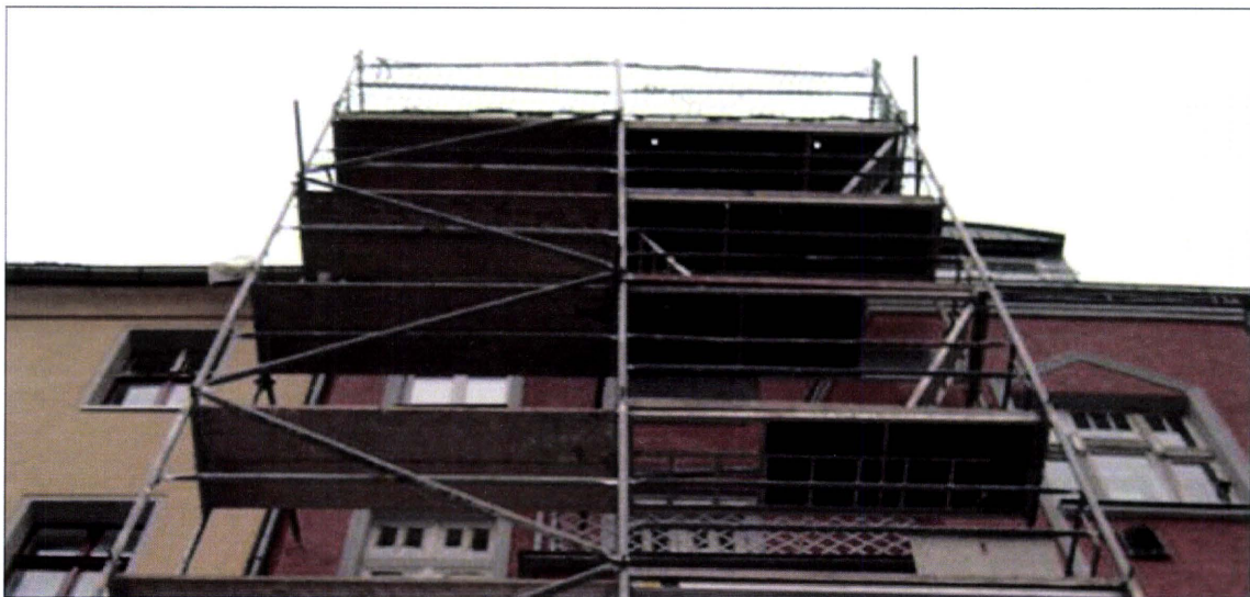
写真3 ドイツで用いられることの多い木製足場板
