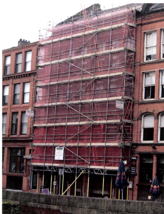
写真 12 イギリスにおける足場の設置状況
