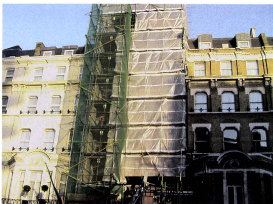
写真 16 足場用シートの設置状況 (日本のようにピンと張っていない)
