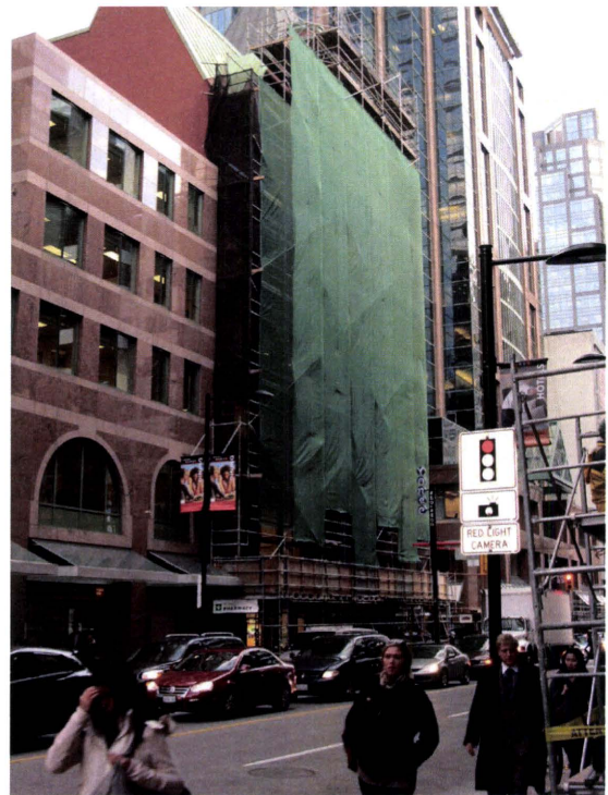
写真 25 トロント市街地における足場の設置状況
