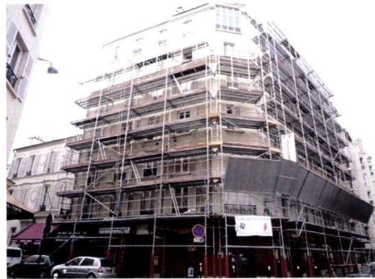
写真 11 朝顔の設置状況
