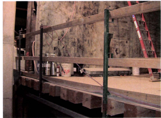
写真 22 2×4 の木材による 2 段手すり（ゴールデンゲートブリッジ改修工事）
