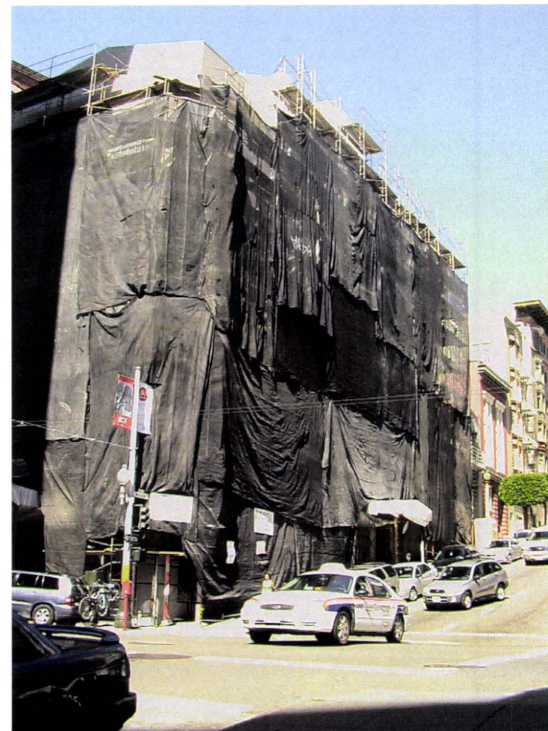
写真 24 メッシュシートを張った足場
