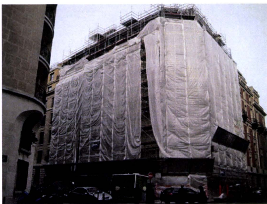
写真 10 足場用シートの設置状況 （日本のようにピンと張っていない）
