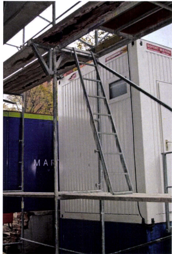
写真2 足場用階段の様子
