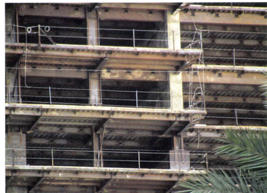
写真 23 ワイヤロープによる 2 段手すり
