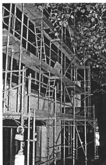
写真1. ドイツにおける足場の設置状況
