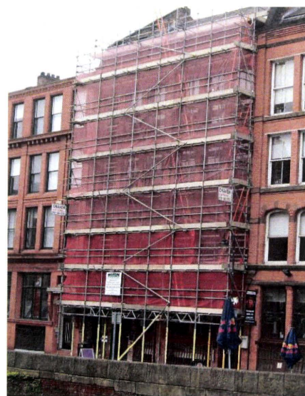
写真1 英国における足場の状況
