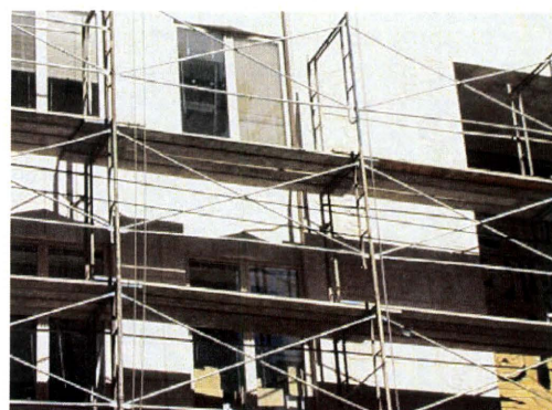
写真2 米国における足場の状況
