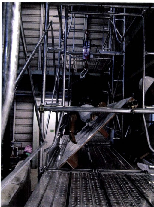
写真 8. 幅木 B の実験前の状況
