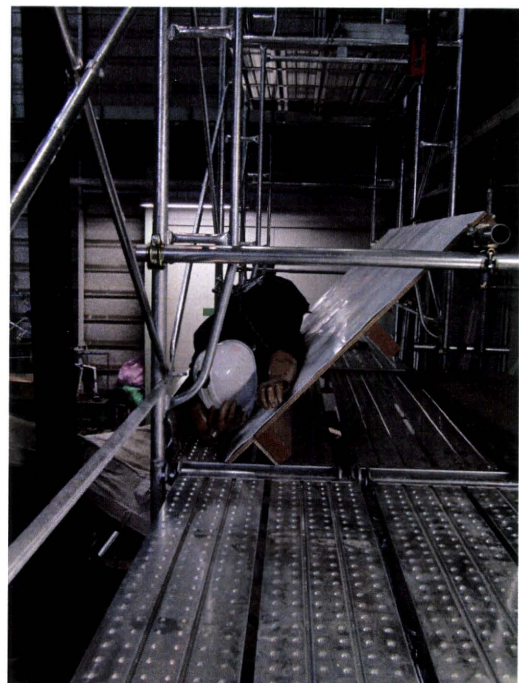
写真 7. 幅木 A の実験後の状況
