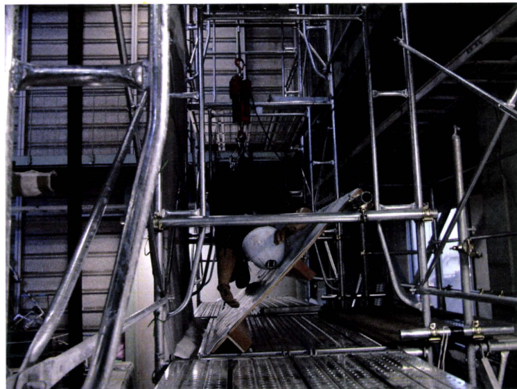
写真1. 衝撃荷重の測定
