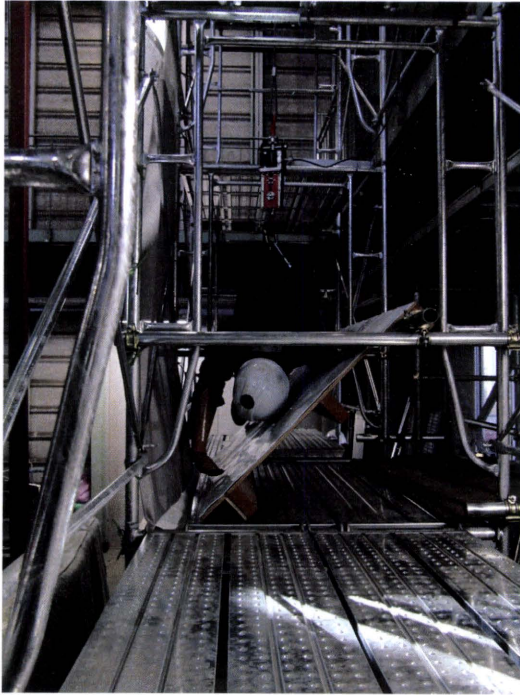
写真 13. 実験 3 の実験前の状況
