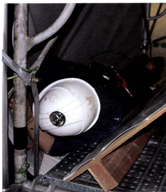
写真 4. Type-1 の実験後の状況 (墜落防止された)
