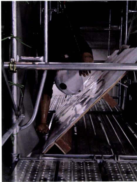
写真7. 防護膜付メッシュシート (間隔 160mm) の実験前の状況
