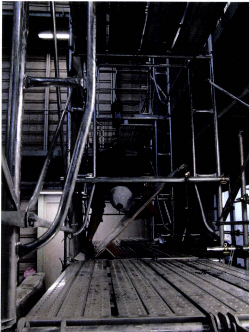
写真 15. 実験 4 の実験前の状況
