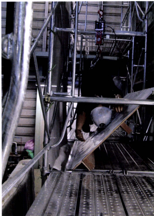
写真 19. 実験 6 の実験前の状況
