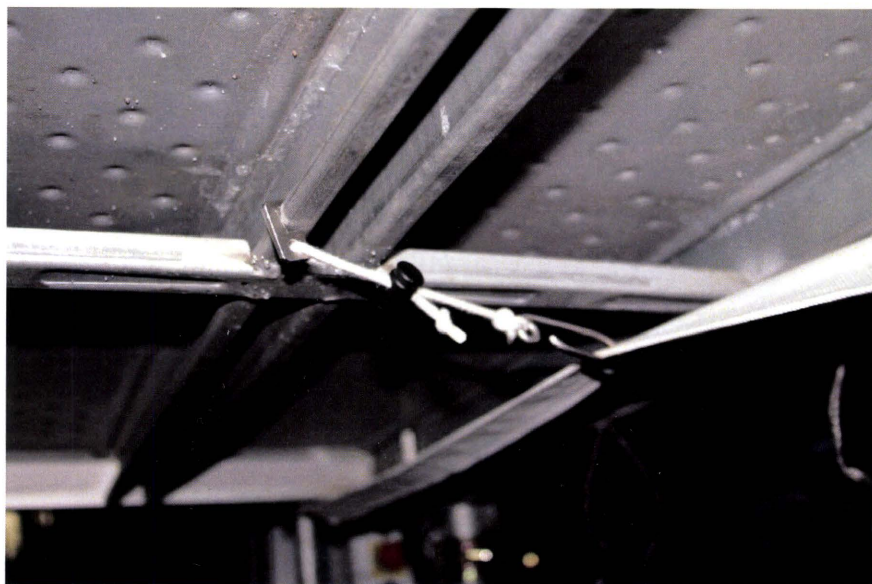
写真1. はとめと床付き布わくを固定するために考案した取付金具 (Type-1 モデル)
