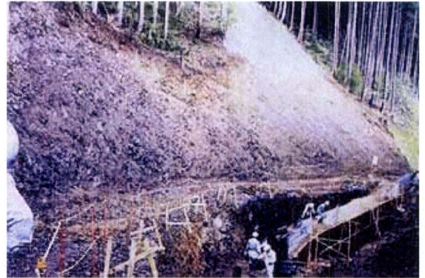
写真-1 斜面下での擁壁工の施工状況
