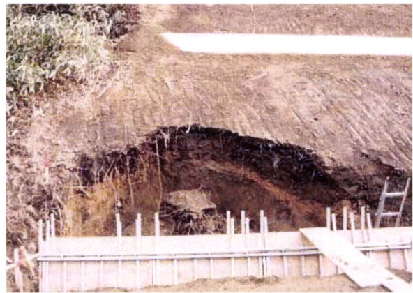
写真-2 型枠解体中の災害事例
