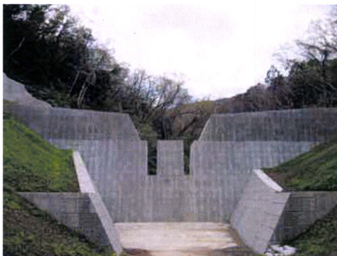
写真-5.1 化粧型枠による砂防堰堤
