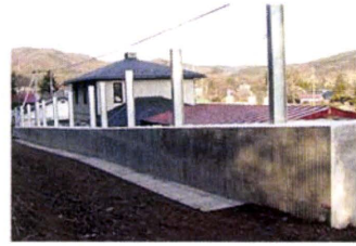
④コンクリート打設・裏込め撤出し転圧
