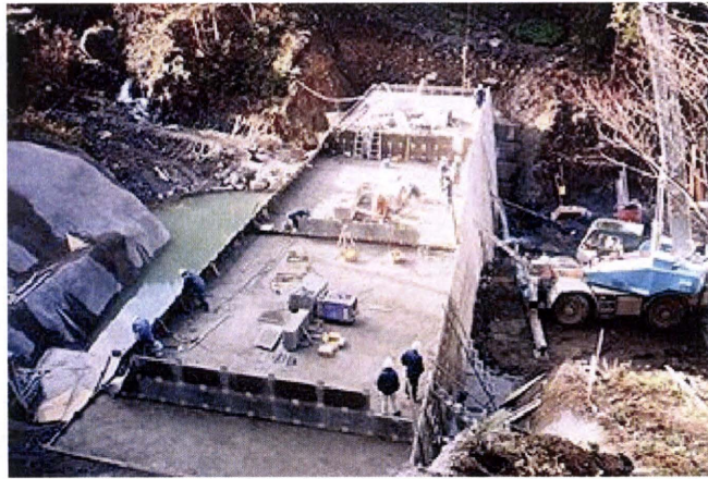
写真-5.2 残存型枠施工中
