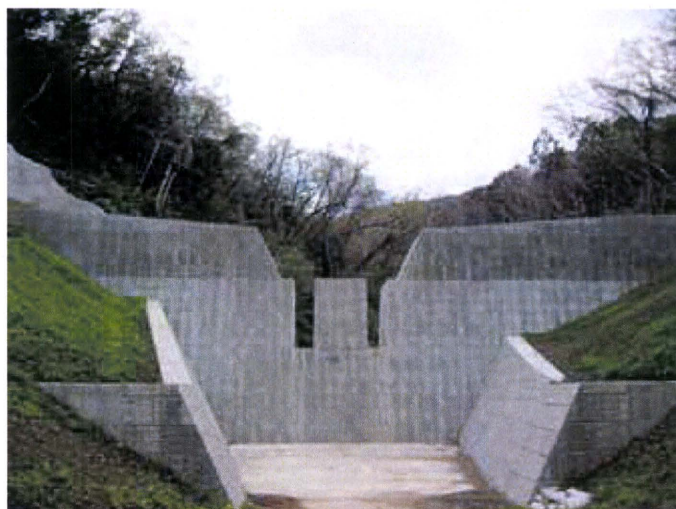
写真-4.1 化粧型枠による砂防堰堤
