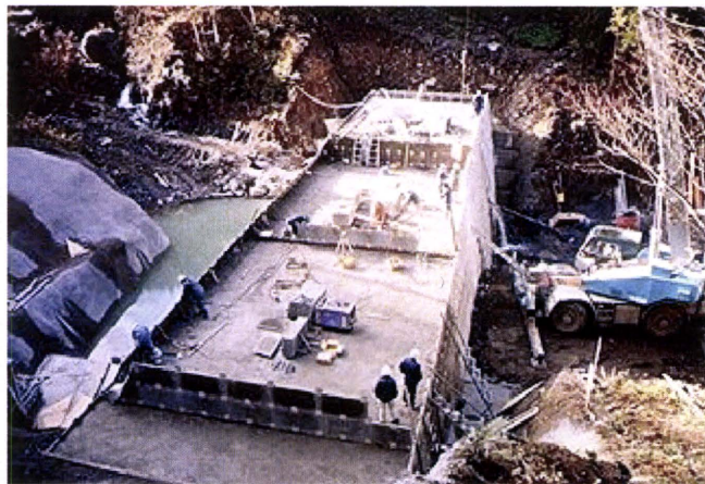
写真-4.2 残存型枠施工中
