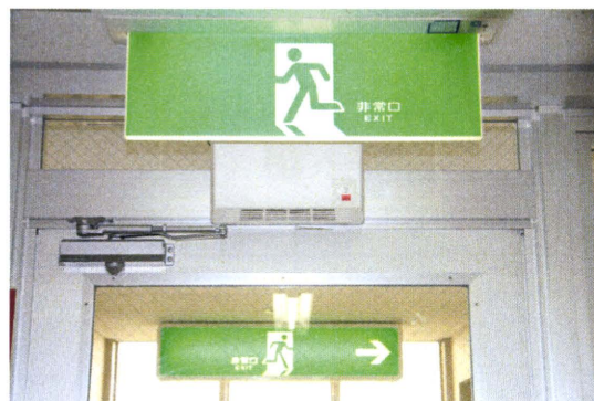
Fig. 16 実証試験時のRN固定局無線局配置 非常口灯の上部の白いケース内に設置
