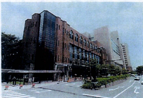
手前は東大病院外来診療棟。その向こうが臨床研究支援センターの入っている中央診療棟2
