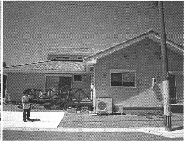
②建物外観
