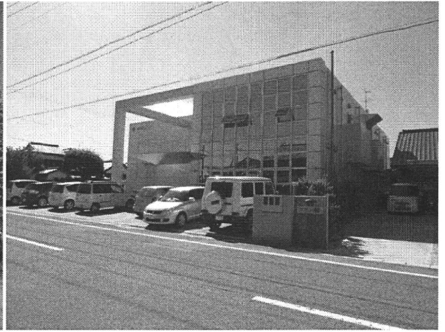
④建物外観（診療所）
