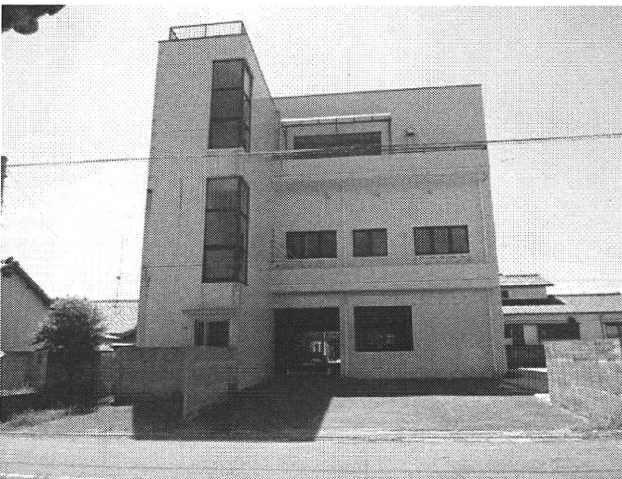
③建物外観（裏側）
