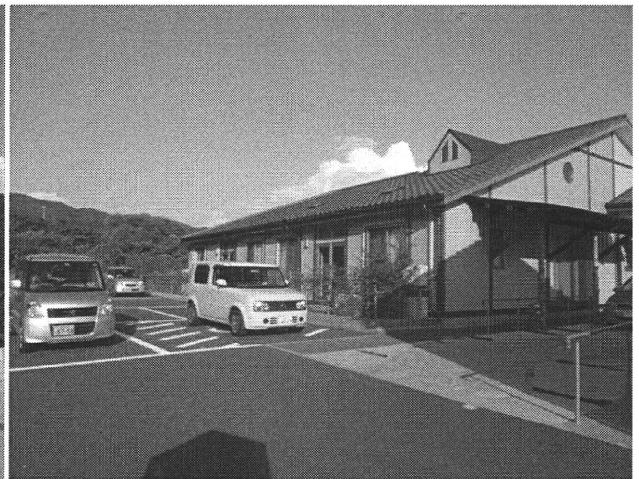
④建物外観（グループホーム）
