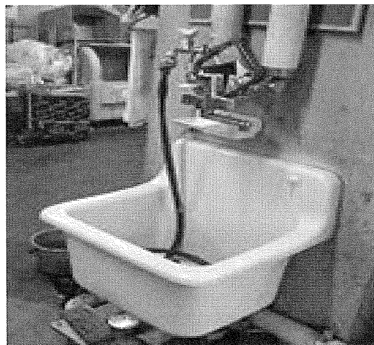
写真 1-2-2 水没したホースの先端
