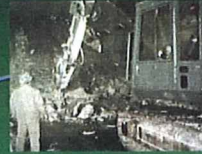
豊浜トンネル 崩落事故 (1996. 2)
