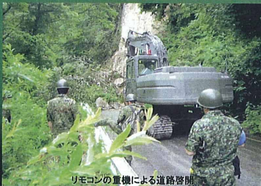
リモコンの重機による道路啓開
