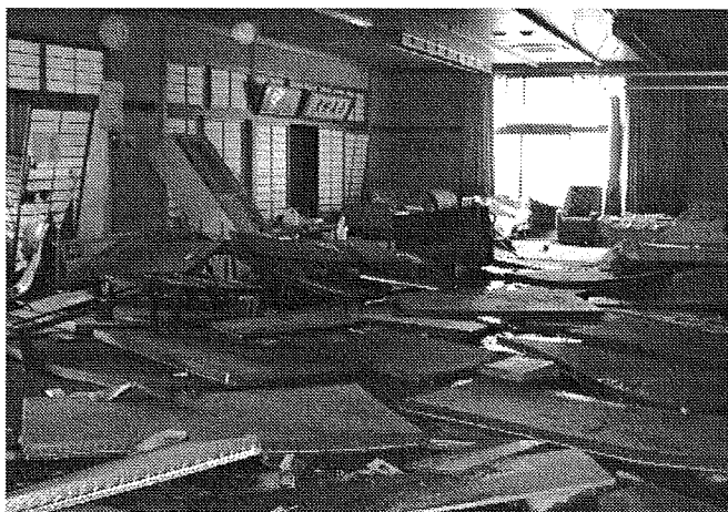
老人福祉センターの被害（上月区）
