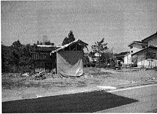
解体後更地となった様子
