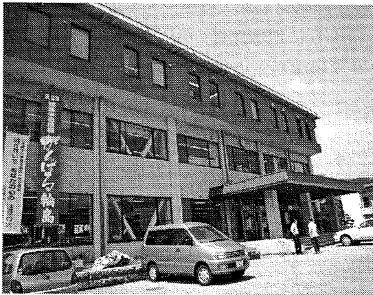
輪島市門前総合支所
