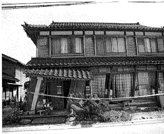
倒壊しかけている家屋 （輪島市門前町道下地区）
