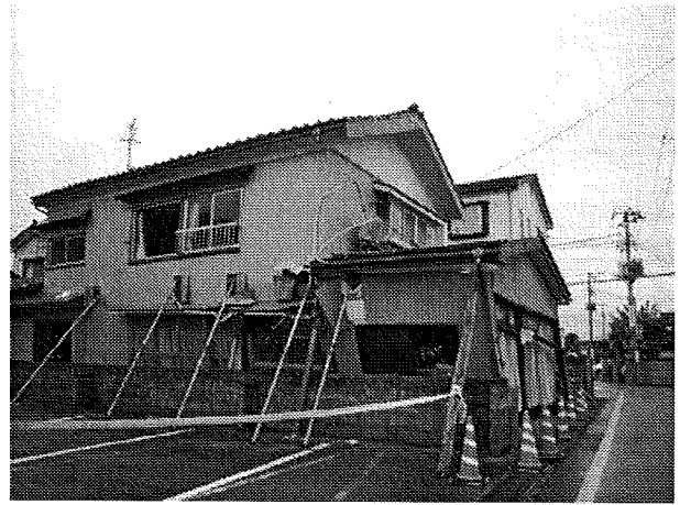
倒壊しかけている家屋 （柏崎市中心部）
