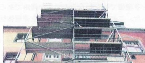
写真2. 足場板の状況
