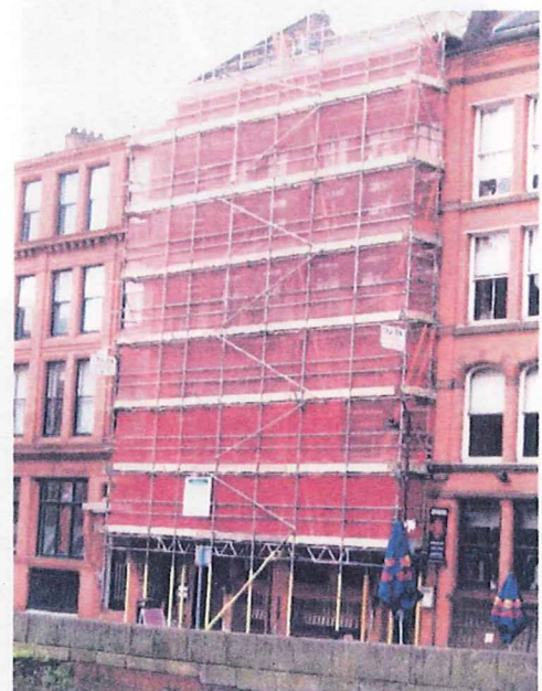
写真1 イギリスにおける足場の設置状況
