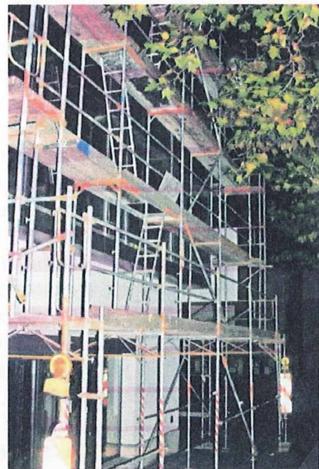
写真1. ドイツにおける足場の設置状況
