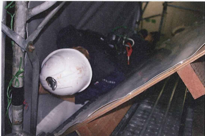
写真 22. 実験 7 の実験後の状況
