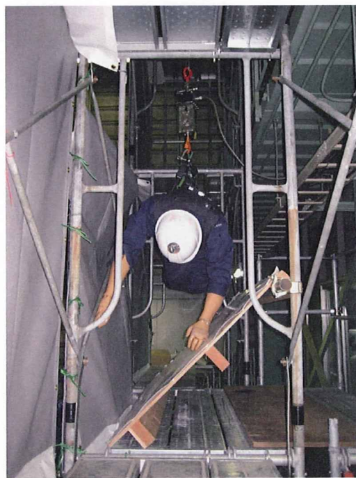
写真 9. 実験 2 の実験前の状況 (1 回目の落下試験)
