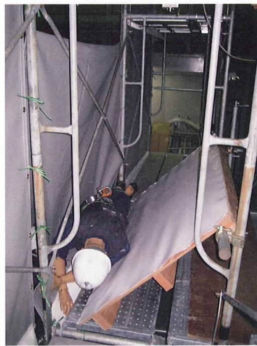
写真 10. 実験 2 の実験後の状況 (1 回目の落下試験)
