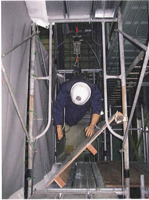
写真 11. 実験 2 の実験前の状況 (2 回目の落下試験)
