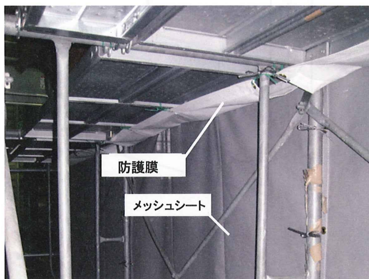
写真1. 防護膜付メッシュシートを足場に設置した状況
