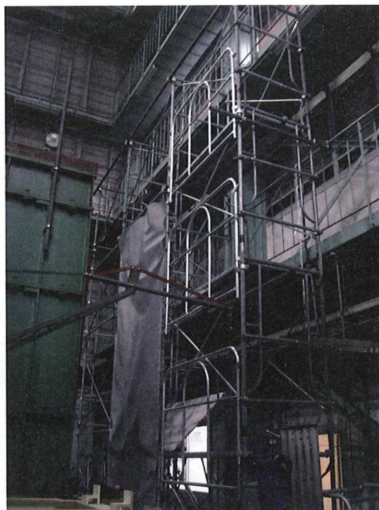
写真1 一部手すり先行工法により組立てた足場
