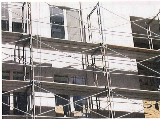
写真2 交さ筋かい+中さん（下さん）を 設置したわく組足場
