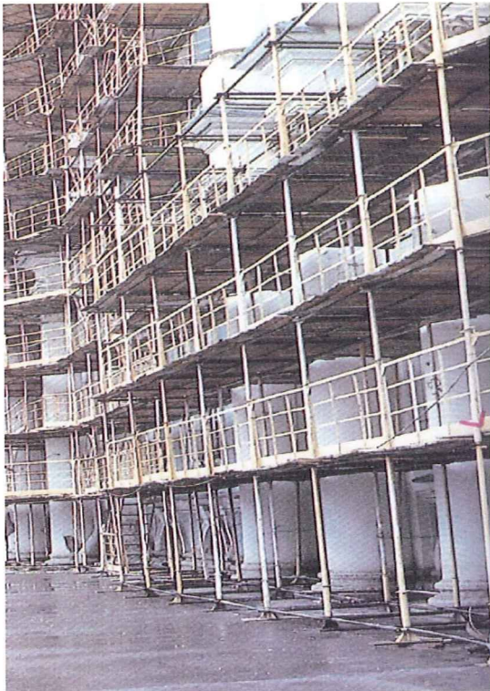
写真 15 タイにおける墜落防止性能の高い足場
