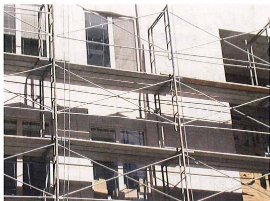
写真1 交さ筋かい+中さん(下さん)を設置したわく組足場
