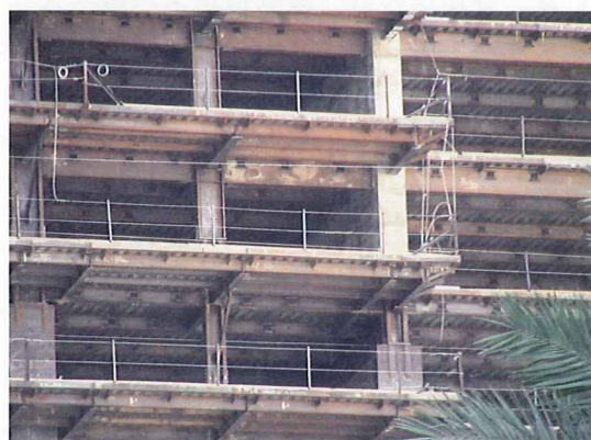
写真4 ワイヤロープによる2段手すり
