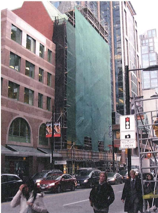
写真6 トロント市街地における足場の設置状況
