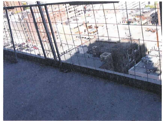
写真8 鉄製支柱にフェンスを設置したもの（写真7を現場内から観察したもの）
