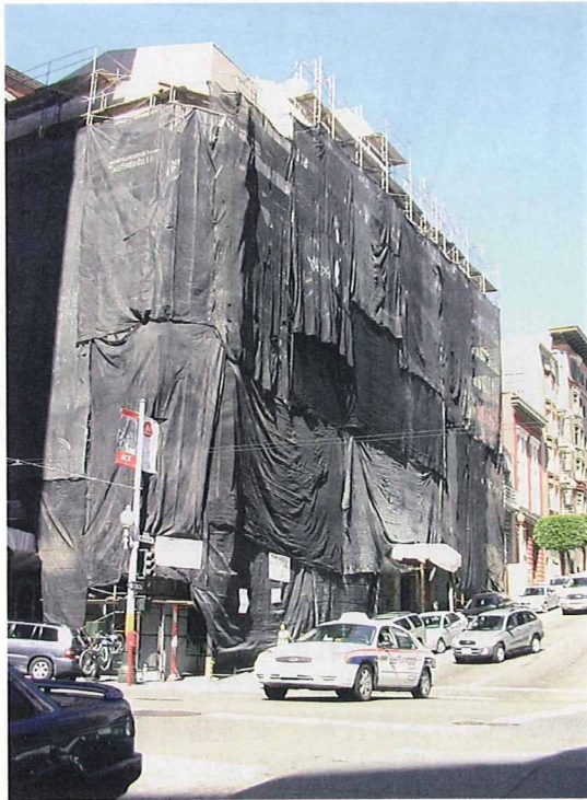
写真5 メッシュシートを張った足場
