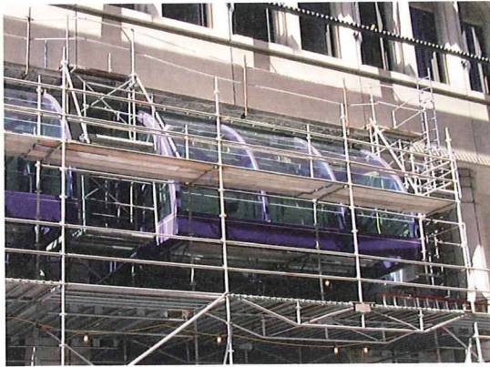
写真1 2段手すりの設置された足場
