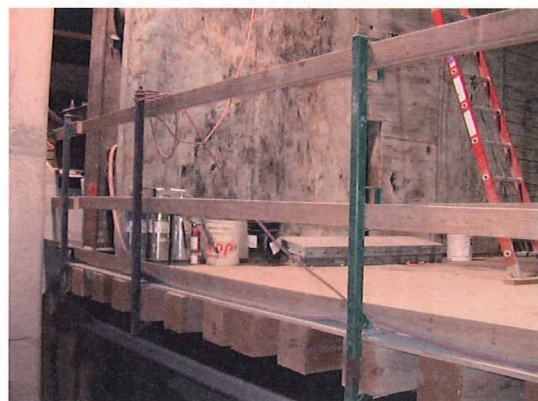
写真3 2×4の木材による2段手すり(ゴールデンゲートブリッジ改修工事)
