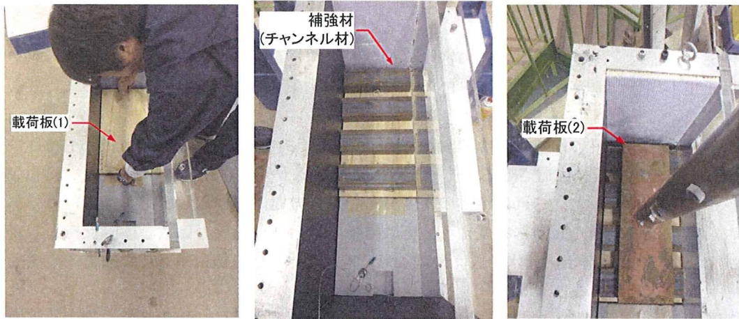
写真 5-4-6 載荷板を設置して地盤を静的に圧縮する様子
