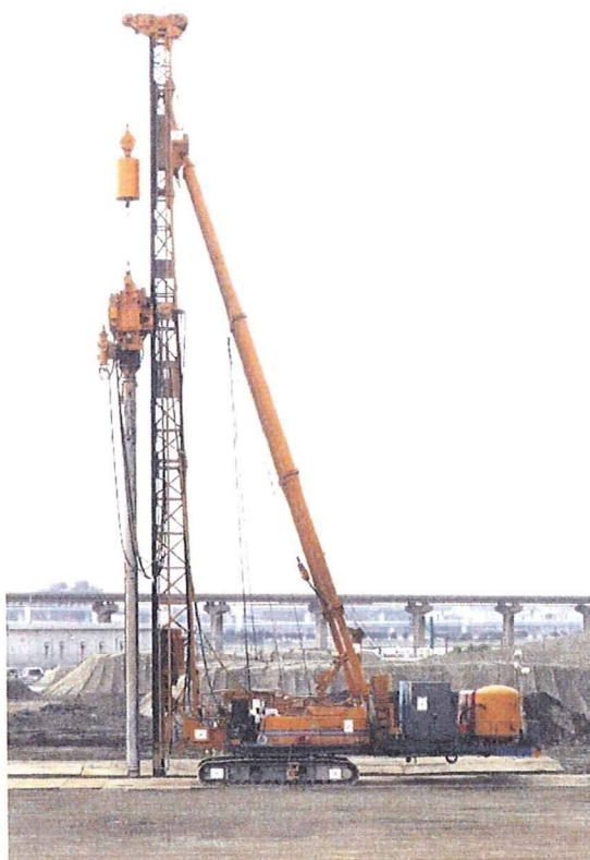
写真 5-2-4 実大走行実験に用いたくい打機の外観
