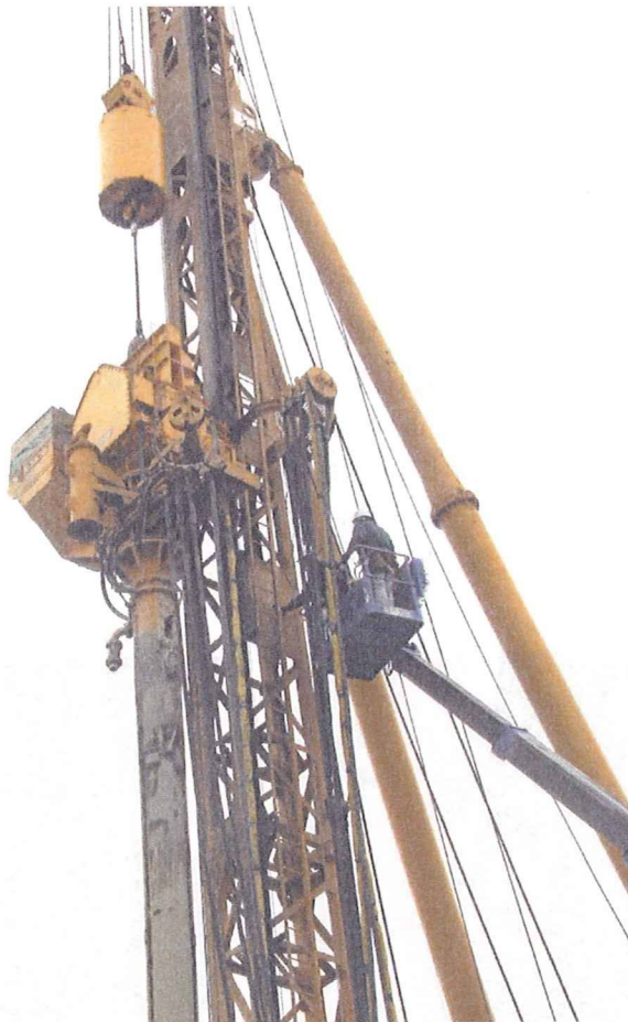
写真 4-5-4 高所作業車にて加速度計 Acc1 を設置する様子
