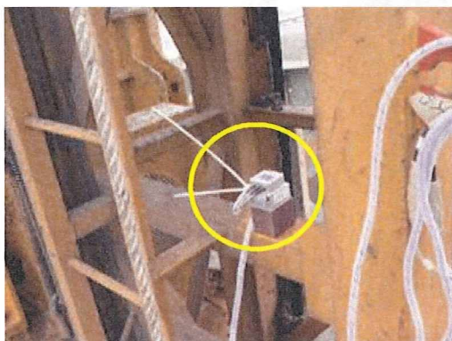
a) Acc1 の設置状況
