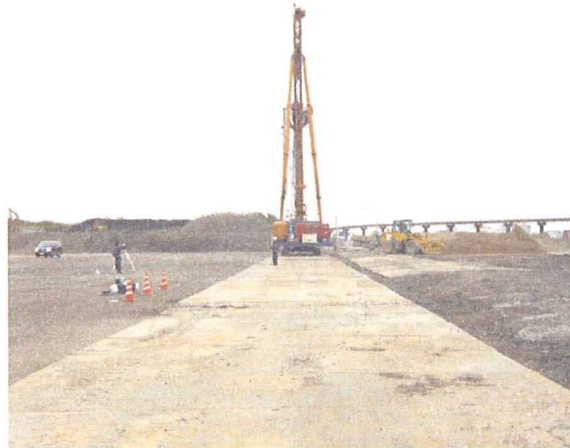
写真 4-5-2 敷鉄板が敷設された走行路の様子
