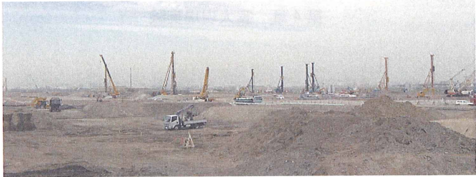
写真 4-1-1 東京国際空港国際線地区エプロン等整備事業の A 工区の様子
