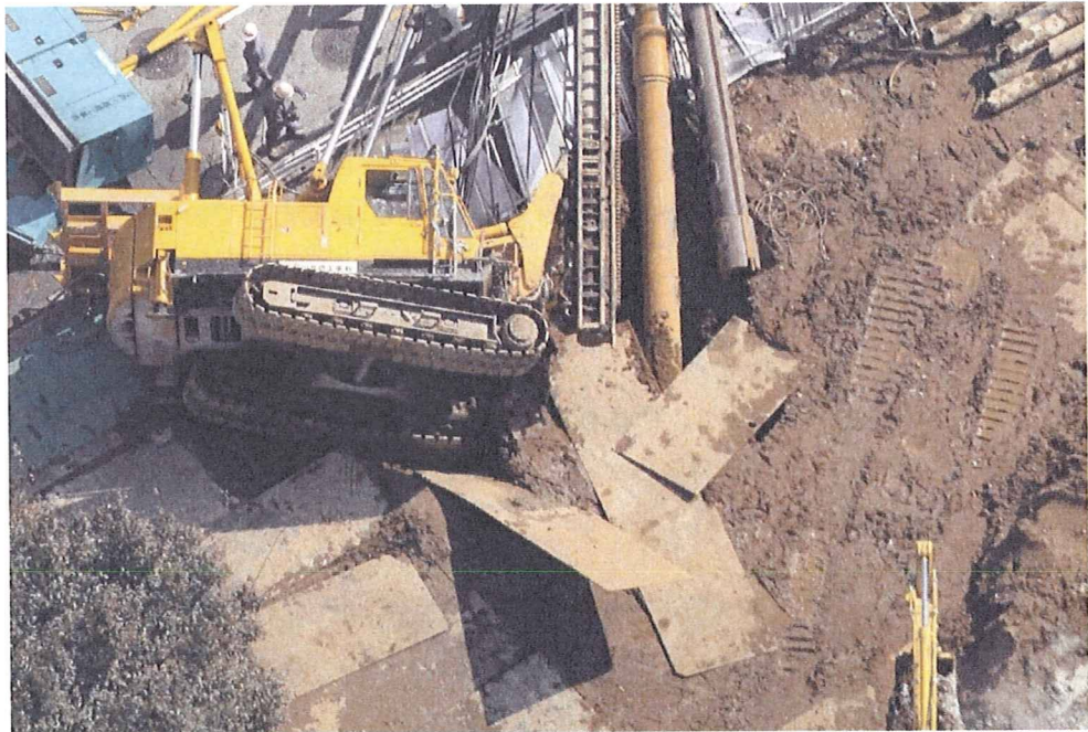
写真 2-2-7 くい抜機の敷鉄板に対する履帯の載荷位置
