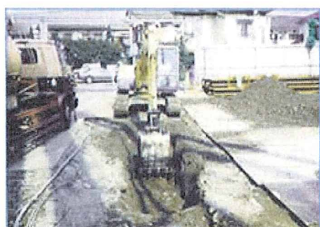
写真 2 SMWの施工に先立って行われる溝掘削
