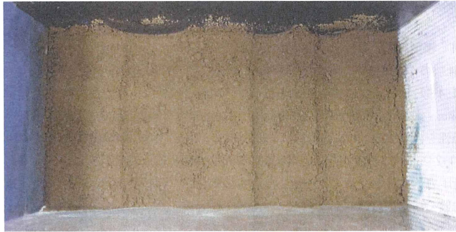
写真 4-11-3 締固め後の様子
