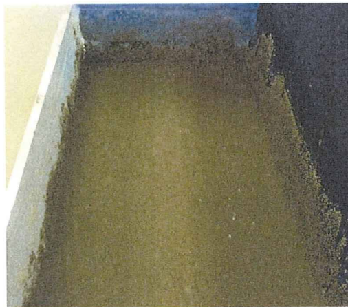
写真 4-9-1 予備荷重終了後の様子
