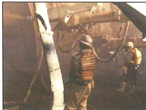
図 1.13 吹き付け作業の様子
