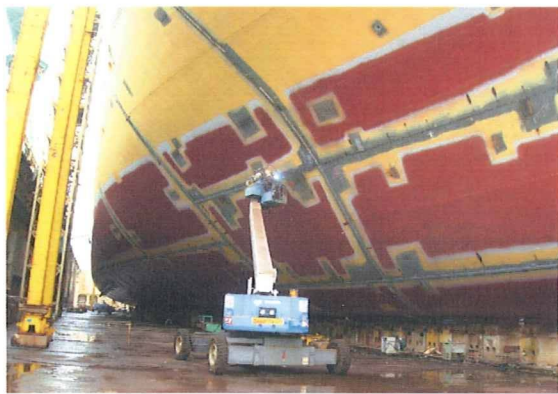
図 3.17 接合部における溶接作業の様子
