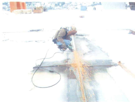
図 3.20 測定現場の研ま作業の様子
