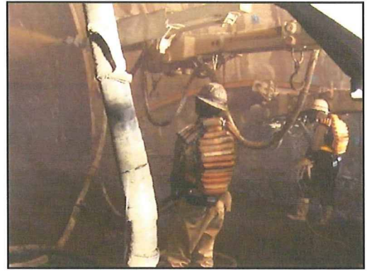
図 1.13 吹き付け作業の様子
