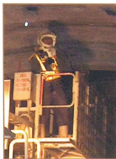
図1.20 重松製作所製フード装着時の作業状況
