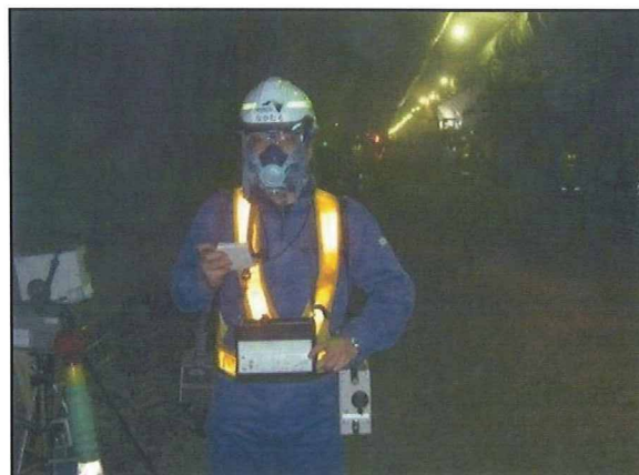
図1.4 測定点での測定状況
