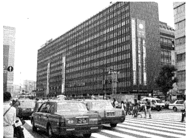
この写真は中央区八重洲から東京駅大丸を観察したものである
