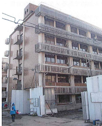
中北棟の工事の様子
