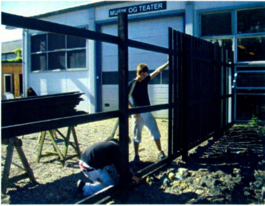
写真8 「木工」が製作する学内の塀
