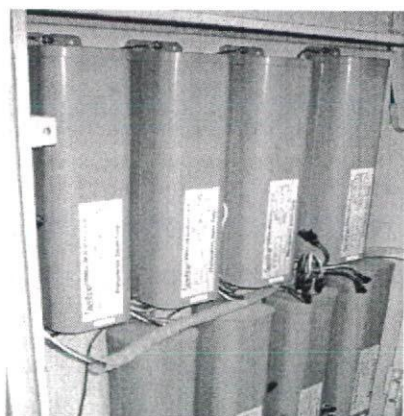
写真2-3 電磁安定器
